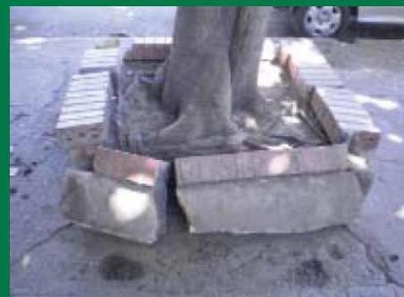
Figura 4.7. Las tazas elevadas no tienen ningún beneficio para el árbol y suelen terminar rotas por la presión de tronco y raíces. En este caso el daño está acelerado e incrementado por que se ha plantado una especie de ficus ( Ficus lyrata ).
