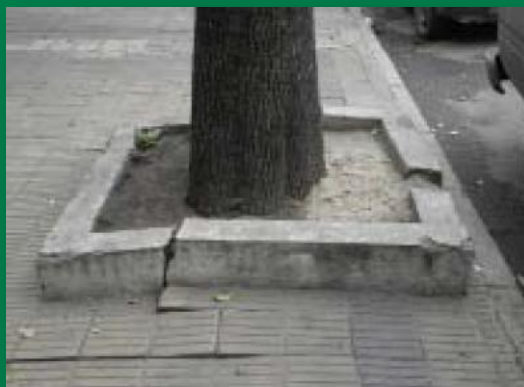
Figura 4.6. Taza elevada dañada por el crecimiento de un fresno.
